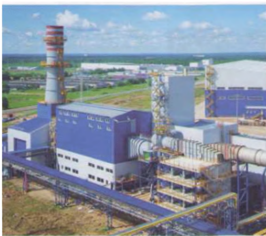
Рисунок 2.57 — НЛМК-Калуга с очисткой пыли в рукавном фильтре
