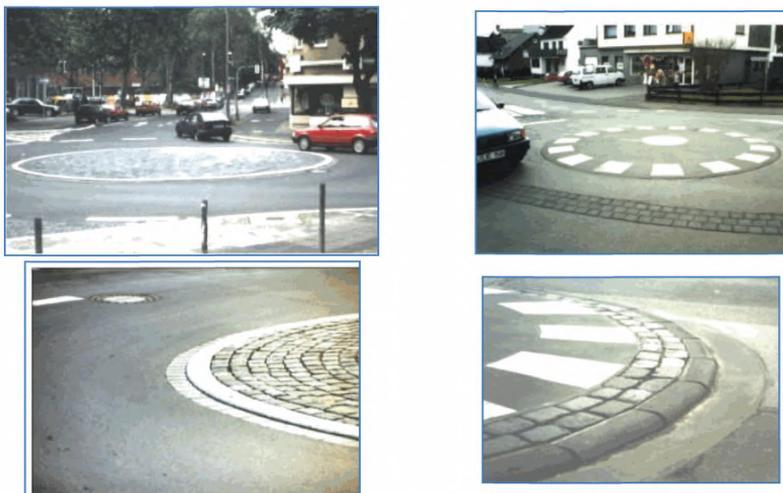
*Рисунок 6.6 - Внешний вид центрального островка мини-кольцевых пересечений [13]*
