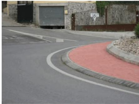
***Рисунок 11.2 – Отличающееся по цвету покрытие краевой полосы центрального островка для заезда задних колес грузовых автомобилей и автобусов***
