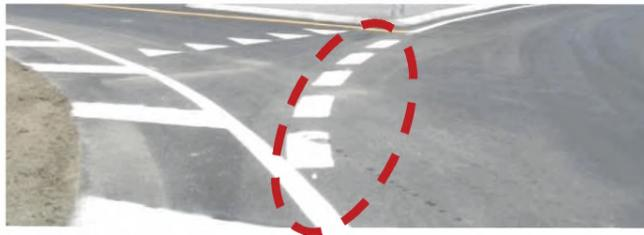
*Рисунок 12.4 – Разметка граничной линии кольцевой проезжей части*
