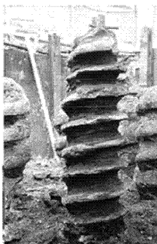
Рис. 8.15. Технология «Атлас»: а - тело сваи в грунте; б - теряемый наконечник
