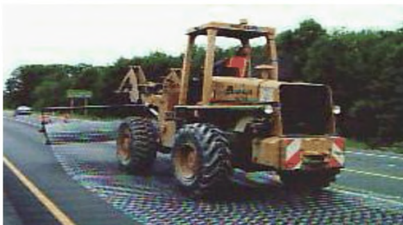
Рисунок 10.1 - Укладки стальной сетки
