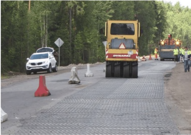
Рисунок 10.5 - Прикатка сетки пневматическим катком
