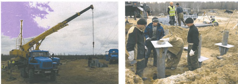
Рис.2.9 - Погрузочно-разгрузочные работы (перемещение нижних балок ростверка); выполнение земляных работ, задание проектной вертикальной отметки, установка опорных столиков и закрепление их к сваям прихваточными сварными швами
