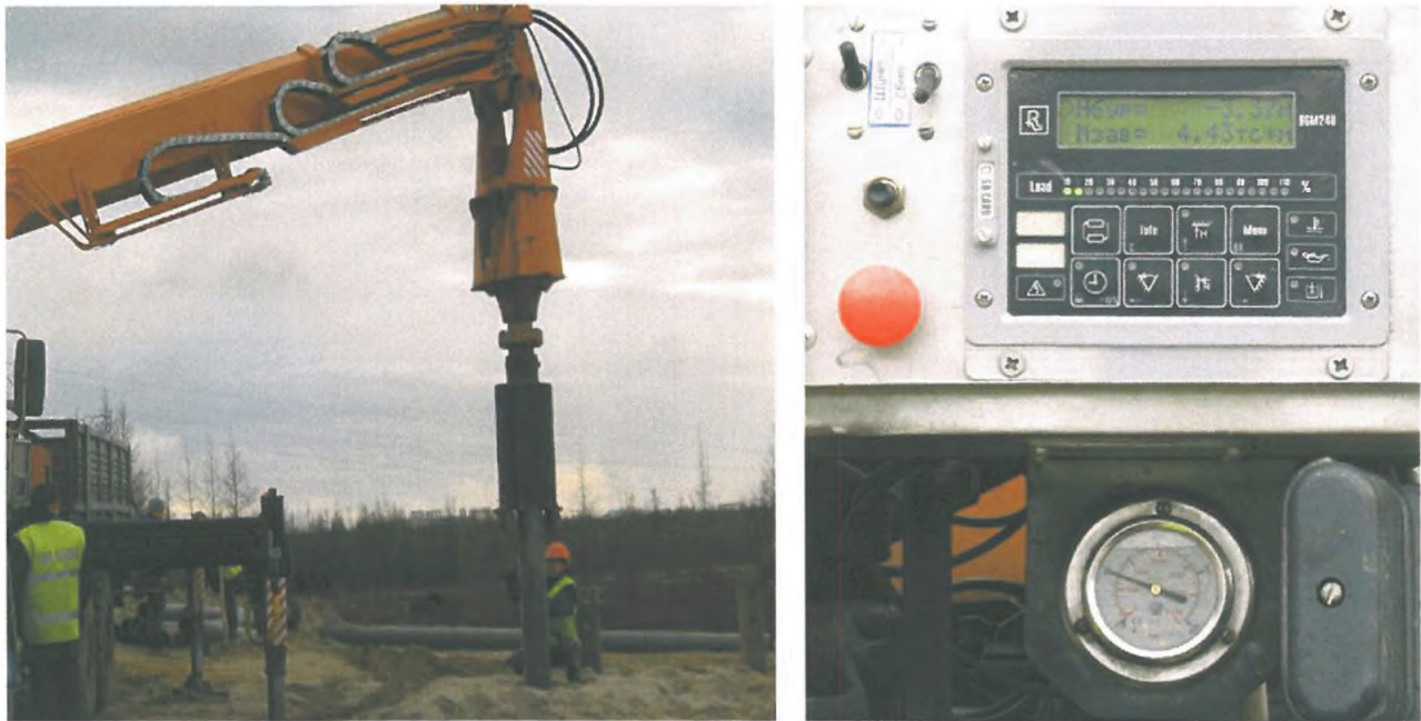
Рис.2.6 - Завинчивание сваи с контролем вертикальности; приборный щиток
