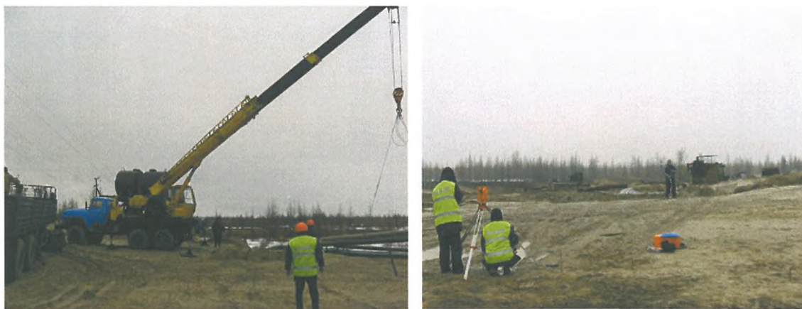
Рис.2.2 - Разгрузка и складирование свай СВЛ-256на стройплощадке; геодезические работы по разбивке осей котлованов - скважин
