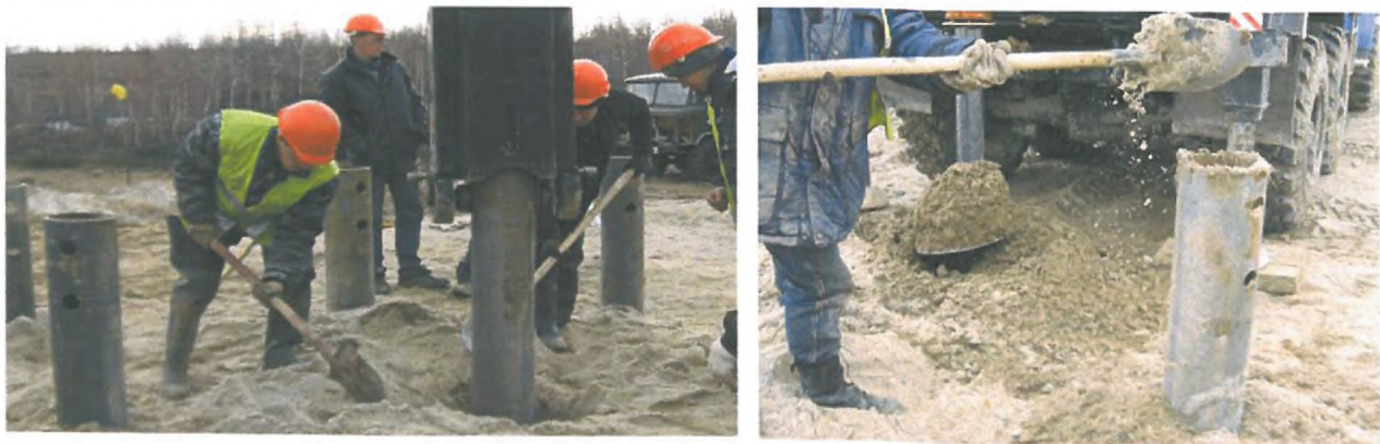
Рис.2.8 - Засыпка пазухи и внутренней полости винтовой сваи
