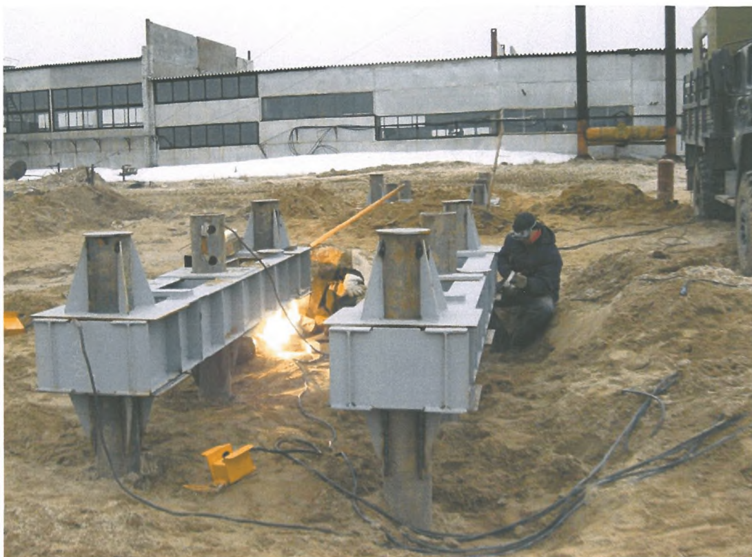
Рис.2.13 - Выполнение работ по зачистке и покраске сварных швов
