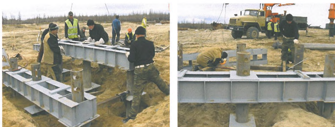
Рис.2.11 - Установка балок нижнего уровня с использованием домкратов; подгонка элементов балок при помощи газовой резки.
