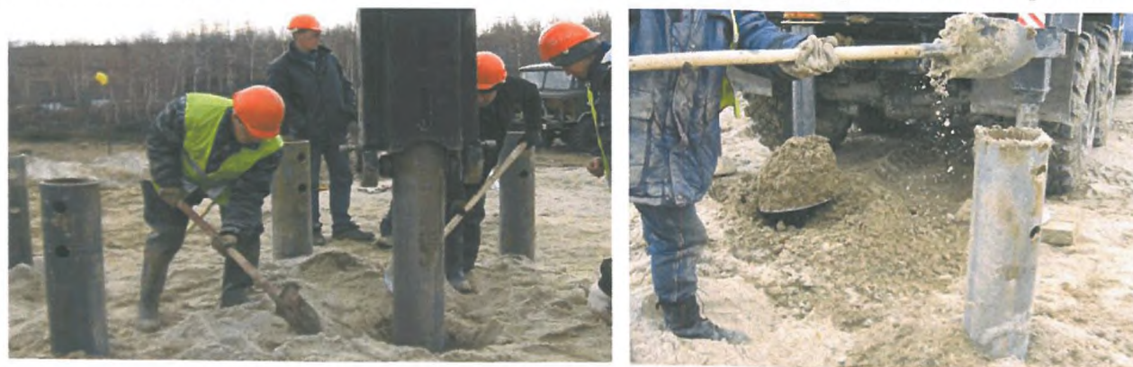
Рис. 2.7 - Контроль вертикальности завинчиваемой сваи; контроль вертикальной отметки сваи; ряд завинченных свай, имеющих отклонения по горизонтали и вертикали
