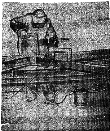
Рис.11. Приварка решетки из уголка на медной подкладке 1
