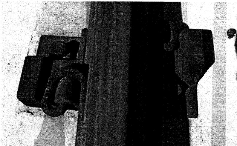
Рисунок 17 – Безрезьбовое упругое нераздельное рельсовое скрепление с одновитковыми торсионными клеммами для железобетонных шпал
