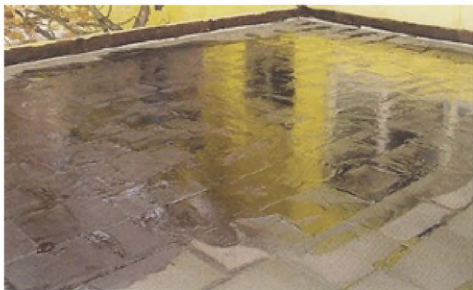
Рисунок 4. Нанесение горячего битума по блокам FOAMGLAS® T4+, S3 или F
