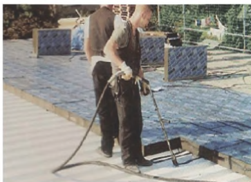
Рисунок 2. Укладка плит FOAMGLAS® READYBOARD на полосы «холодной» мастики
