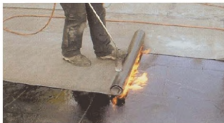
Рисунок 5. Устройство подстилающего слоя из наплавляемого рулонного материала
