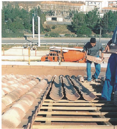
Рисунок 8. Выполнение слоев покрытия:
