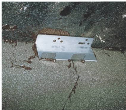
Рисунок 13. Анкер для скрытого крепления PC – Anker F фирмы FOAMGLAS®
