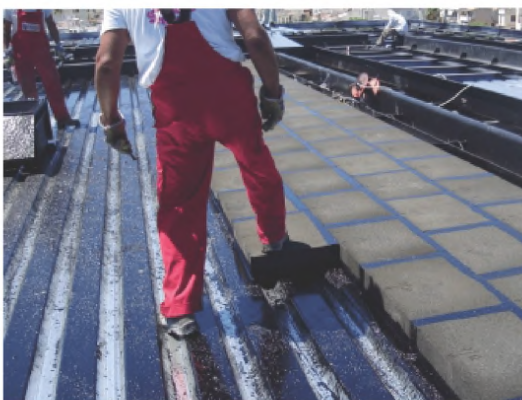
Рисунок 1. Укладка блоков FOAMGLAS® T4+, S3 или F на горячий битум
