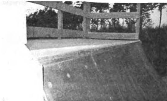
*Рисунок E.3* — Эскалатор — наклонная часть копинга
