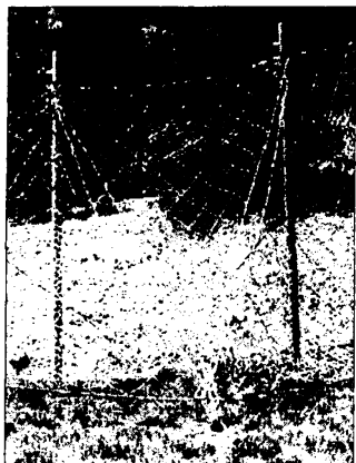
Рис. 37. Конструкции противоналедных сеток: 1 – усиливающие канаты; 2 – стойки барьера; 3 – стальной канат (трос)
