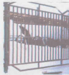
Заполнение штакетником из прямоугольных труб 28x25x1,5
