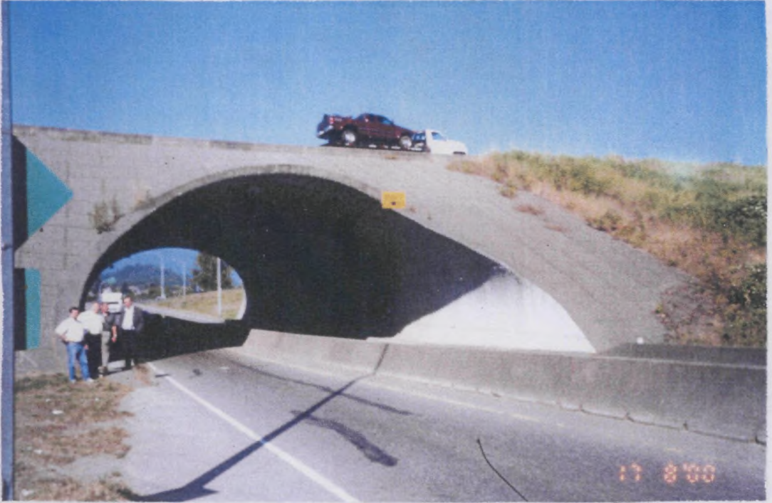
Фото 3. Тоннель для пропуска автомобилей и пешеходов под дорожной насыпью
