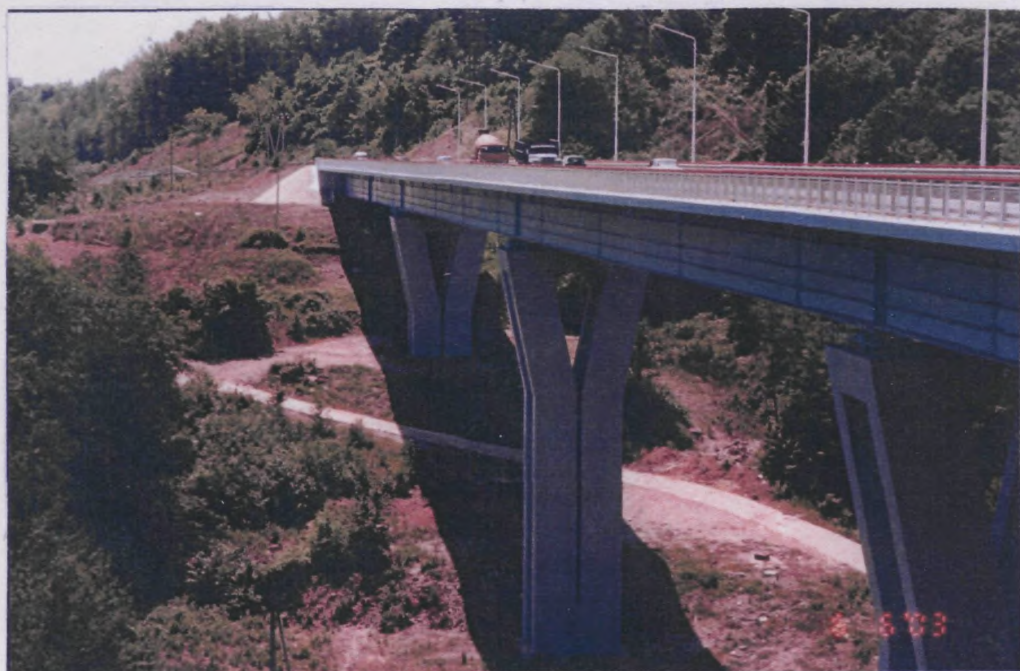
Фото 8. Виадук на ПК36 обхода г. Сочи
