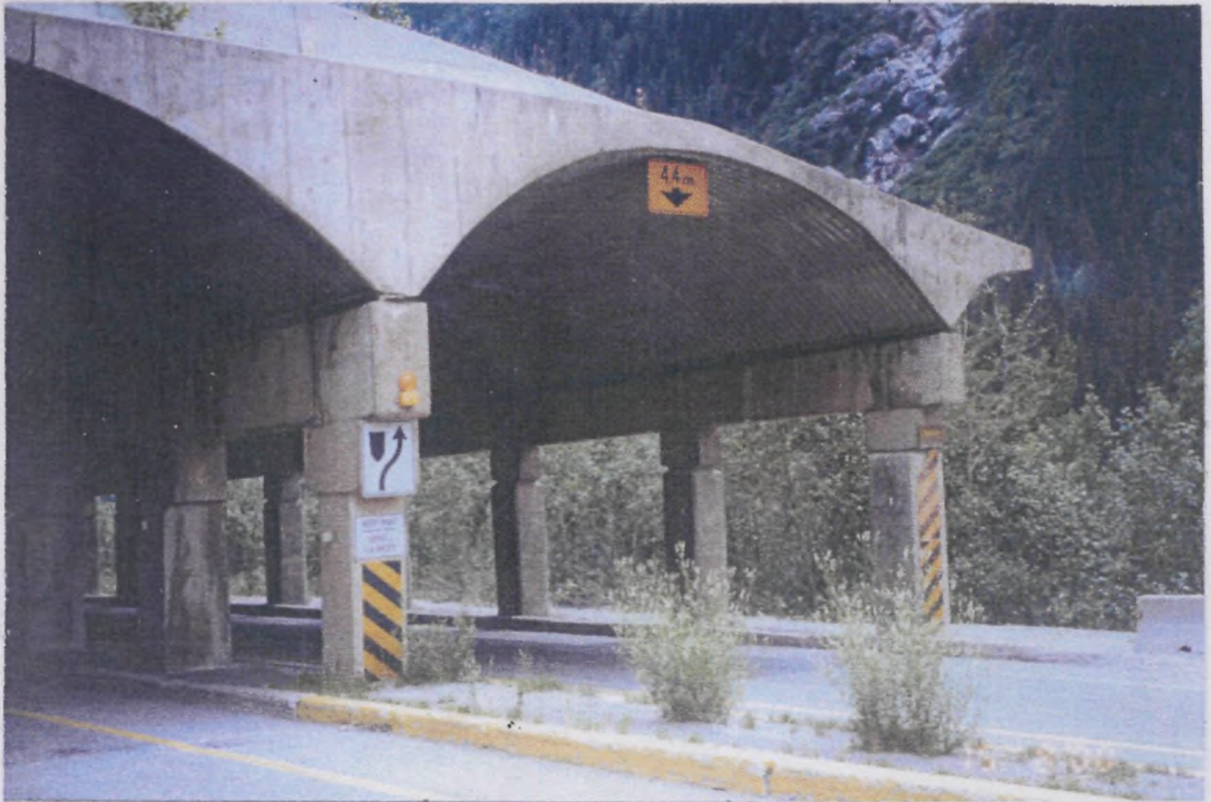
Фото 4. Лавинозащитная галерея со сводом из ГМК
