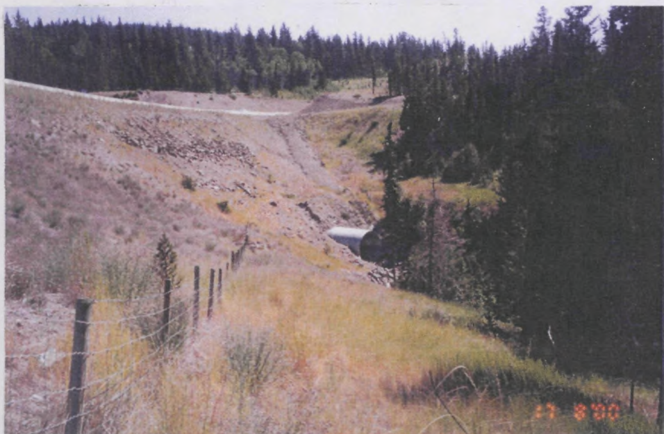
Фото 1. Труба большого диаметра под насыпью автомобильной дороги
