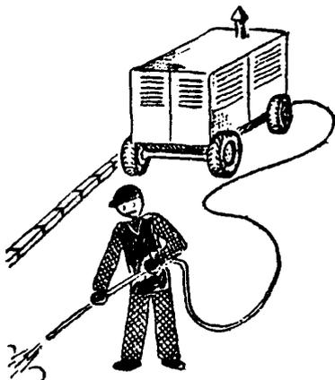
1. Очистка швов и трещин от пыли и грязи с применением стальных крючков и щеток с продувкой воздухом
