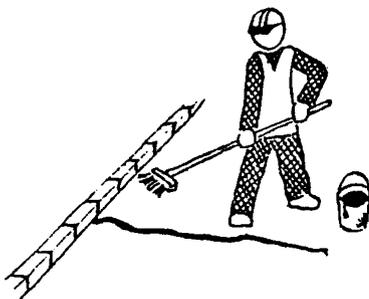
3. Тщательная промывка вертикальных стенок швов и трещин жидким битумом при помощи жесткой щетки
