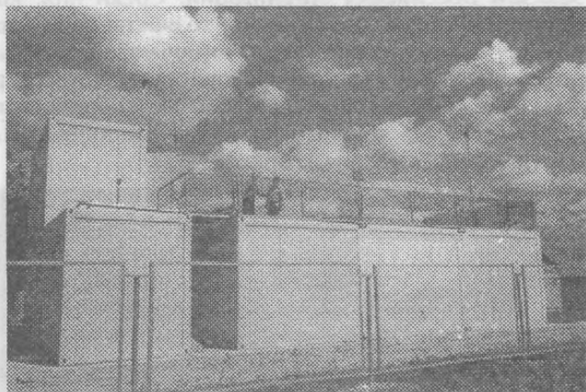
УСТАНОВКА ОЧИСТКИ БЫТОВЫХ СТОЧНЫХ ВОД ПРОИЗВОДИТЕЛЬНОСТЬЮ 200 м 3 /сут (продолжительность строительства — 3 месяца)
