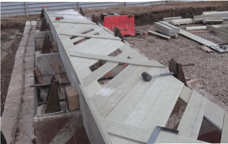
Рисунок В.4 – Сборка фермы на монтажном столе
