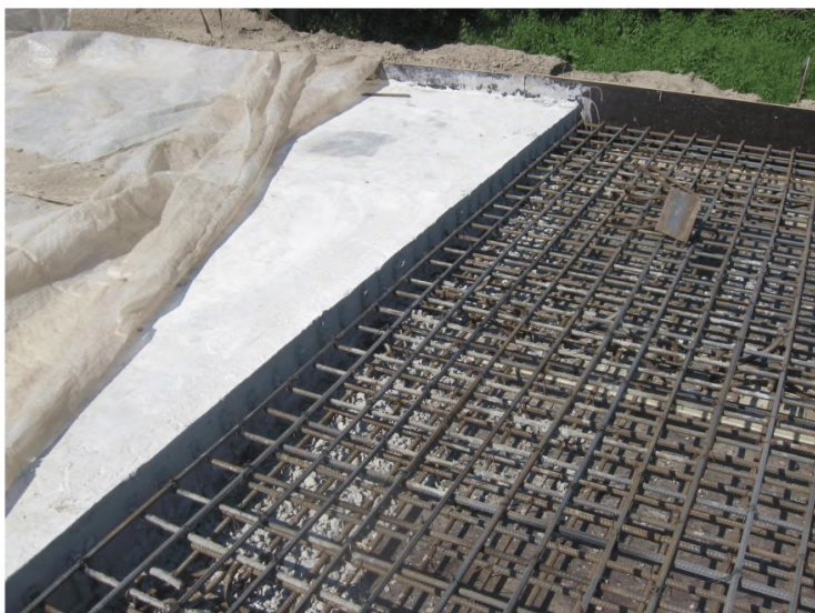
Рисунок В.10 – Устройство железобетонной плиты
