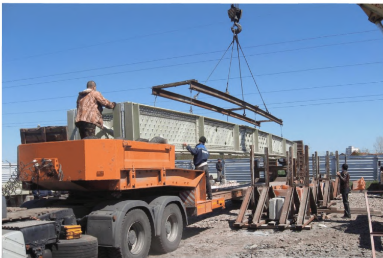
Рисунок В.7 – Погрузка монтажного блока на трейлер
