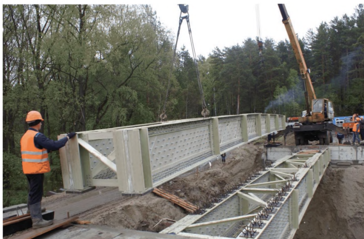
Рисунок В.8 – Установка монтажного блока в пролет
