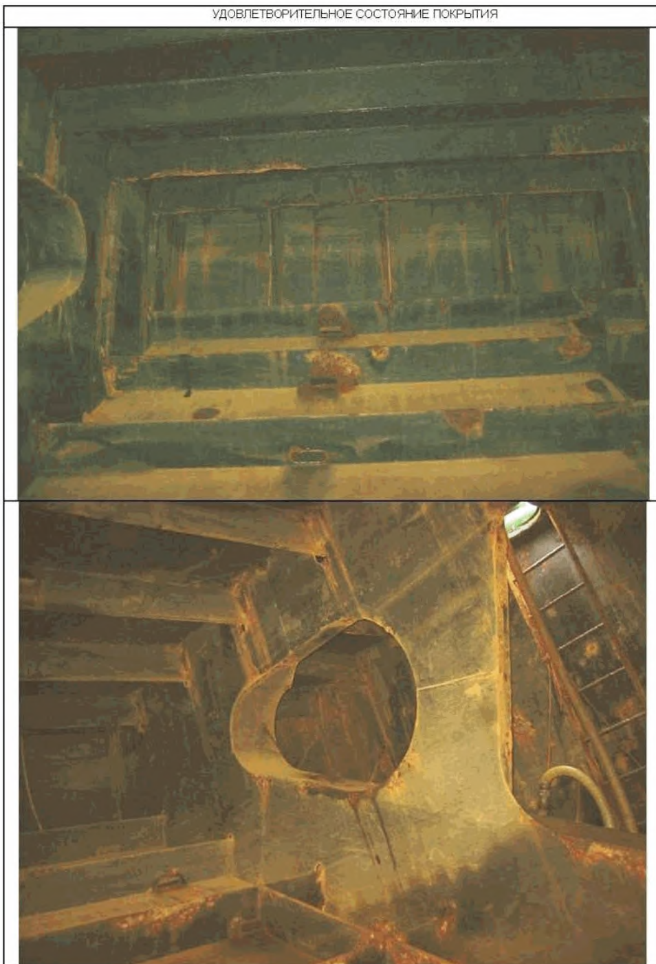
УДОВЛЕТВОРИТЕЛЬНОЕ СОСТОЯНИЕ ПОКРЫТИЯ
