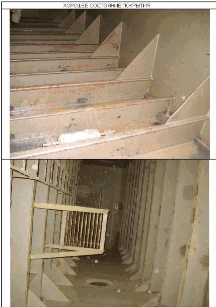
ХОРОШЕЕ СОСТОЯНИЕ ПОКРЫТИЯ
