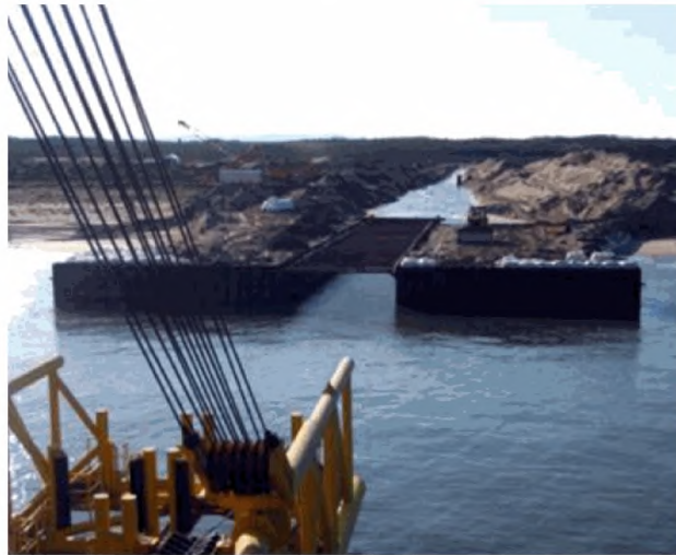
Рис. 10.2-4 Коффердам для протаскивания трубопровода на берег на Киринском месторождении о. Сахалин
