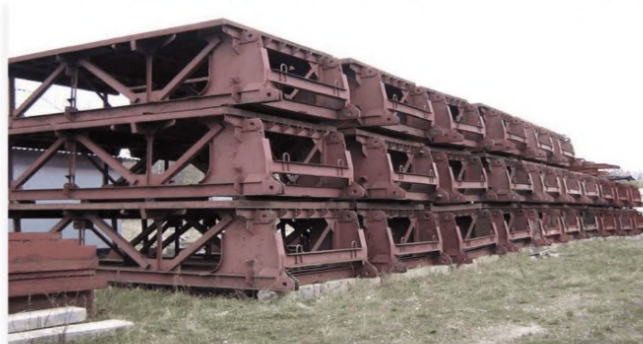
Рисунок 4 – Пример складирования концевых секций моста
