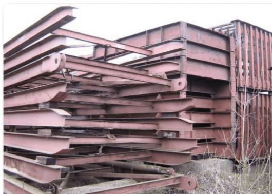
Рисунок 5 – Пример складирования конструкций аванбека моста
