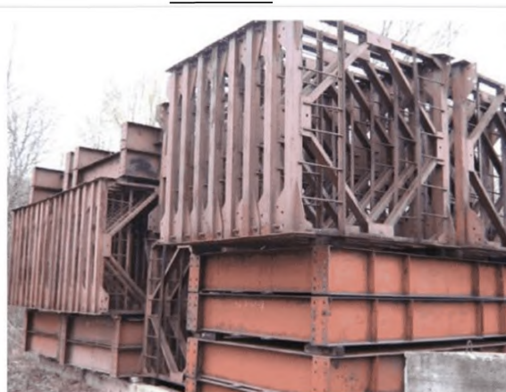
Рисунок 6 – Пример складирования элементов надстройки промежуточных опор моста
