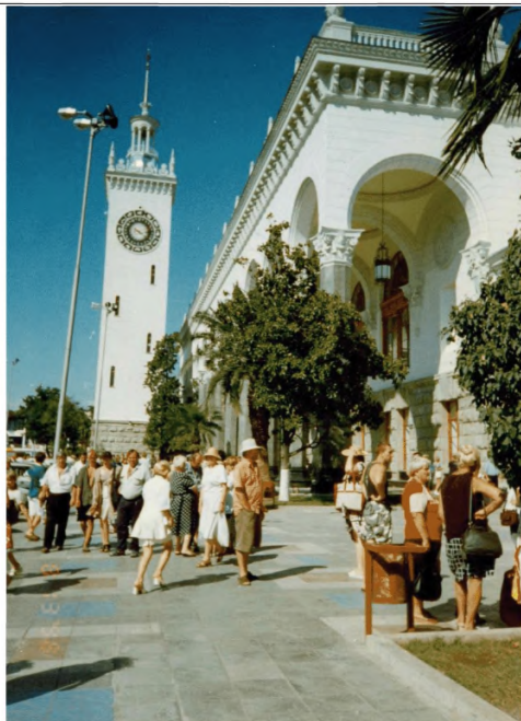
Рисунок Т.1 – Здание железнодорожного вокзала в г. Сочи после капитального ремонта
