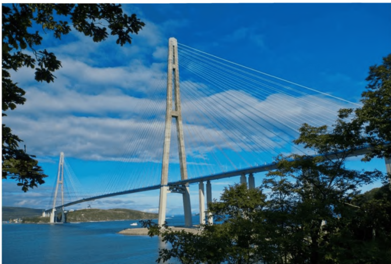
Рисунок Ж.5 – Пилоны моста через пролив Босфор Восточный (фото «СК МОСТ»)
