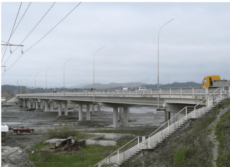
Рисунок С.3 – Общий вид моста через р. Мзымту до реконструкции
