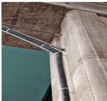
Рисунок П17 – Конструкция водосбросного трубопровода на опоре
