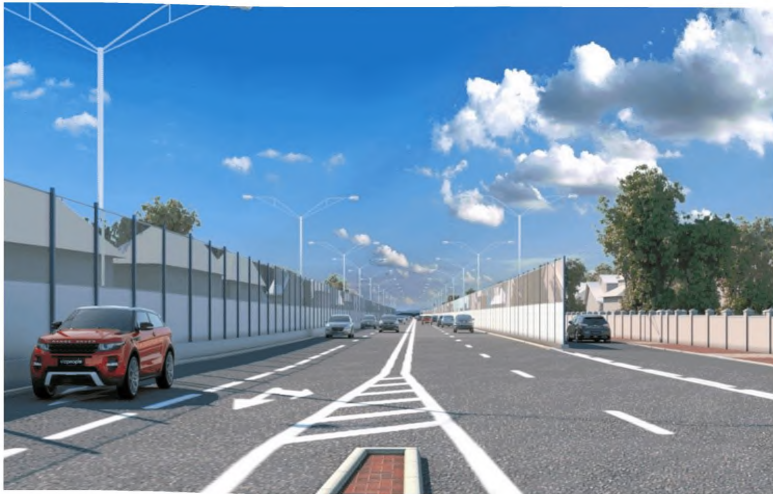
Рисунок Д.8– Пример установки шумозащитных экранов с устройством местного проезда в улицы населенного пункта
