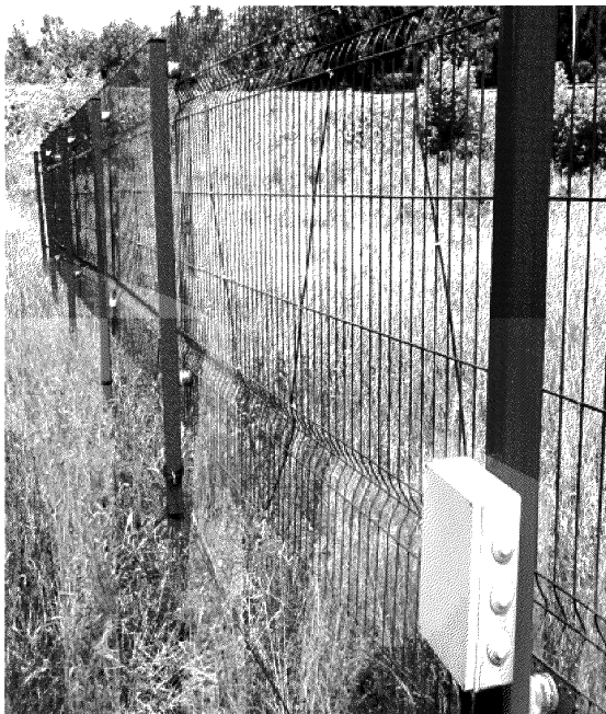
Рисунок 33 – Пример установки извещателя «Рубеж» на металлическом ограждении
