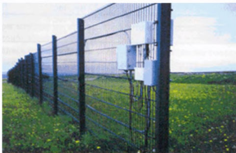
Рисунок 2.39 – Пример установки извещателя
