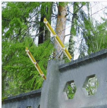
Рисунок 2.52 – ЧЭ комбинированного проводного извещателя «Дуэт»
