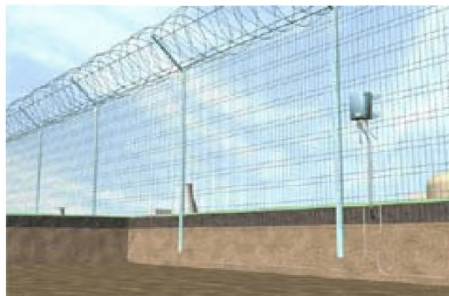
Рисунок 2.24 – Установка ЧЭ для определения подкопа
