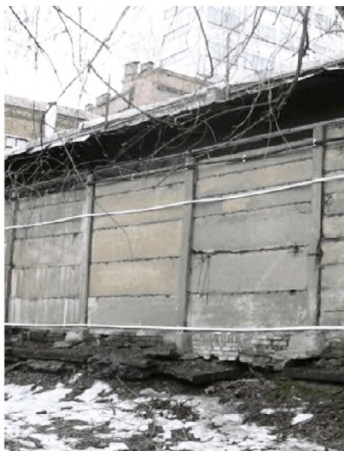
Рисунок 2.21 – Установка ЧЭ на кирпичной стене
