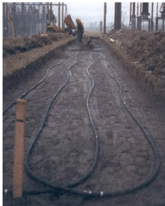
Рисунок 2.34 – Установка шлангов
