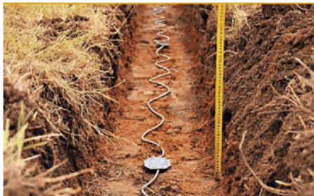
Рисунок 2.30 – Установка геофонов
