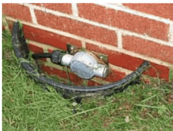
Рисунок 2.28 – Геофон под землей на кирпичной стене
