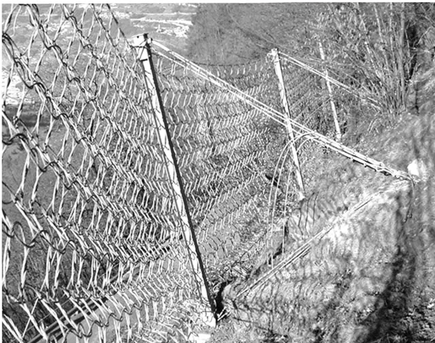
Рисунок А.2 – Пример противокампанепадного барьера из кольчужной сети (фотография с сайта компании «Гео-Барьер» http://www.geobarrier.ru/projects )
