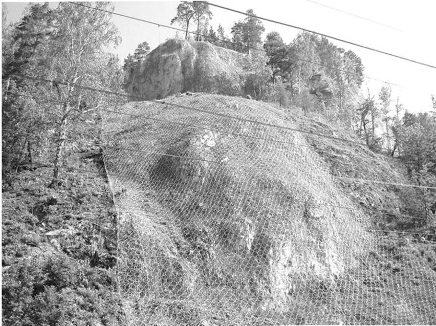
Рисунок А.1 – Пример противокампанепадной заветы из кольчужной сети (фотография с сайта компании «Гео-Барьер» http://www.geobarrier.ru/projects )
