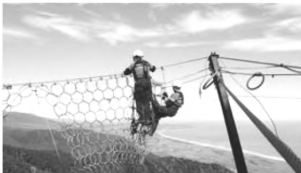
Рисунок 23 – Монтаж секции кольчужной сети на несущий канат
