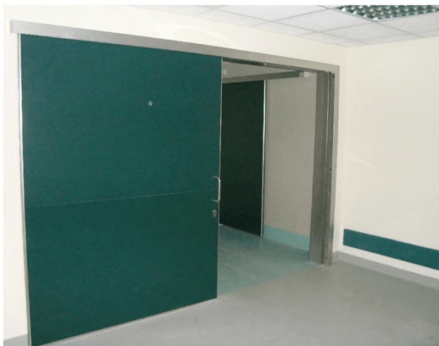
Рисунок 109 – Пример установки раздвижной двери при входе в отделение реанимации
