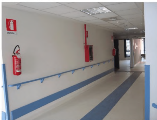
Рисунок 99 – Пример оборудования палатного отделения первичными средствами пожаротушения
