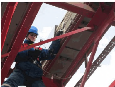
Рисунок Д.3 – Установка акустического датчика на кожух токопровода ТКЛ
