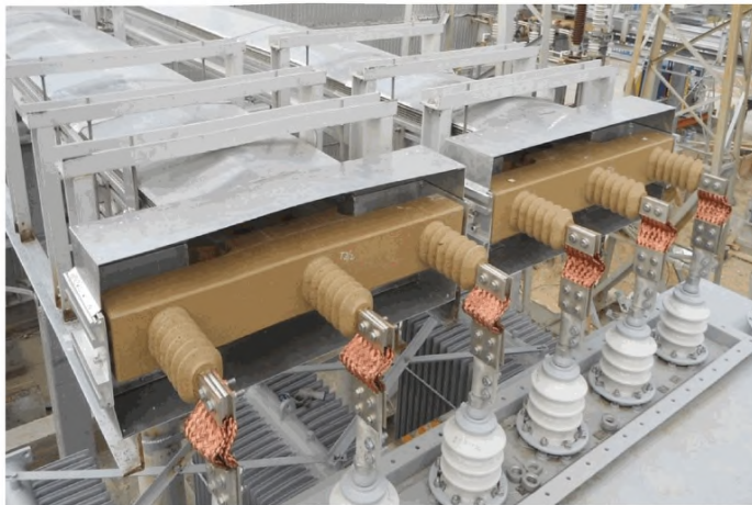
Рисунок Б.4 – Токопровод типа ТКЛ и узел подключения к проходным изоляторам
