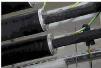
Рисунок Г.1 – Установка датчика типа ВЧТТ на поводок заземления секции токопровода ТПЛ
