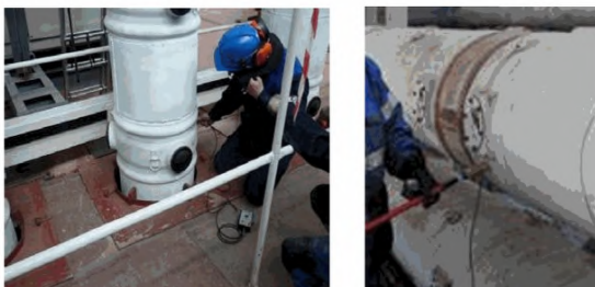
Рисунок Д.2 – Установка акустического датчика на кожух экранированного токопровода
