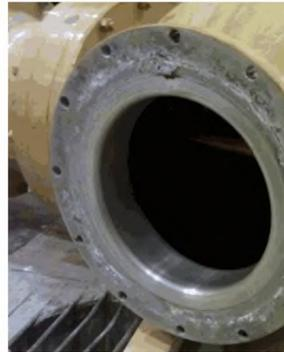
Рисунок 4 - нагрев болтового соединения объемов КРУЭ
