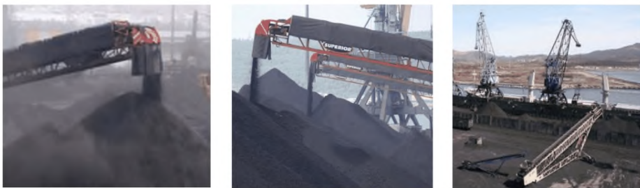
Рисунок 70 –Источники пыления в конвейерных транспортных системах
