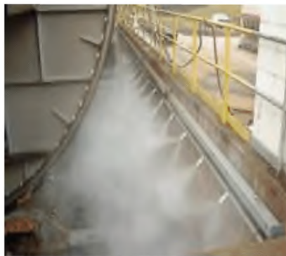
Рисунок 76 – Пылеподавление в СРВ
