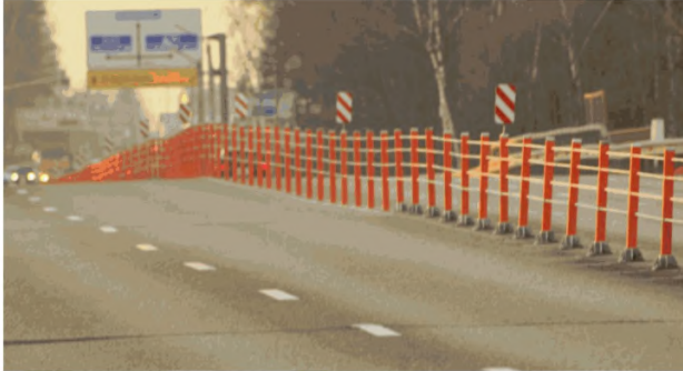
Рисунок 17 - Установка тросового ограждения на мостовом сооружении
