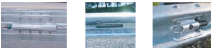
Рисунок 13 - Крепления троса к балке барьерного ограждения
