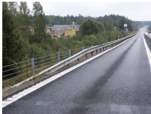
Рисунок 11 – Переходный участок тросового ограждения
