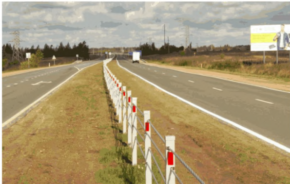
Рисунок 18 - Установка тросового ограждения на разделительной полосе
