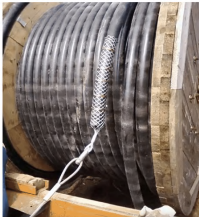
Рисунок 1 – Протяжка кабеля с использованием кабельного чулка
