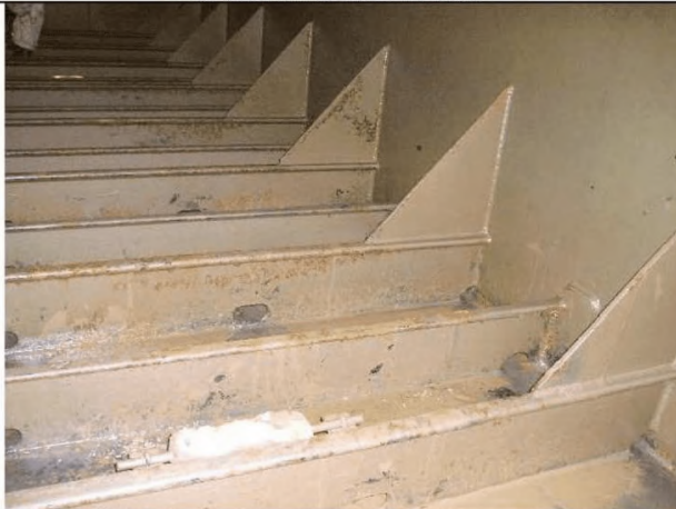
ХОРОШЕЕ СОСТОЯНИЕ ПОКРЫТИЯ
