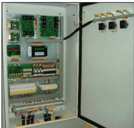
Рисунок 5. Тиристорный (электронный) АВР.
