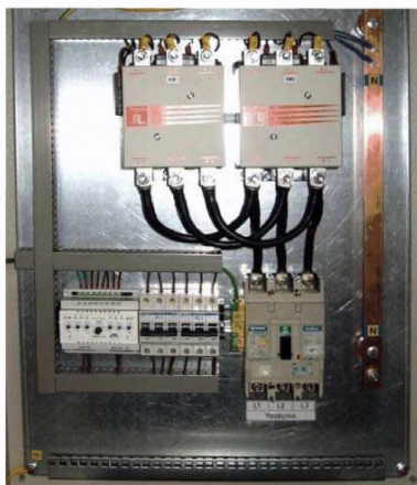
Рисунок 6. Электромеханический АВР.
