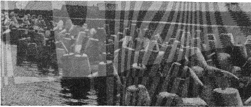
Рис. 20. Оградительное сооружение из наброски тетраподов
