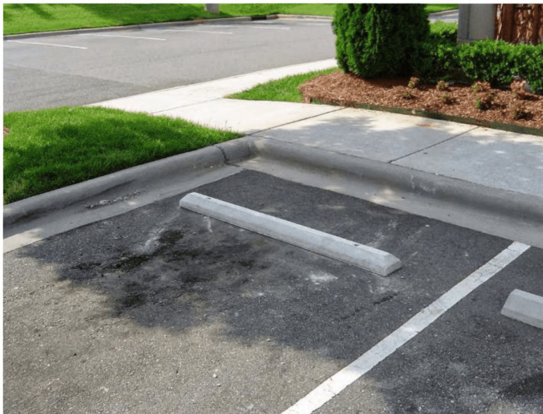
Рисунок 12.1 – Предохранительный валик, препятствующий расположению свеса автомобиля над тротуаром, велосипедной дорожкой или полосой, газоном
