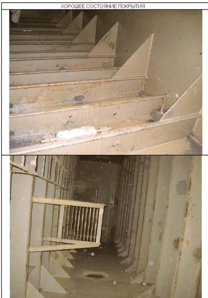
ХОРОШЕЕ СОСТОЯНИЕ ПОКРЫТИЯ
