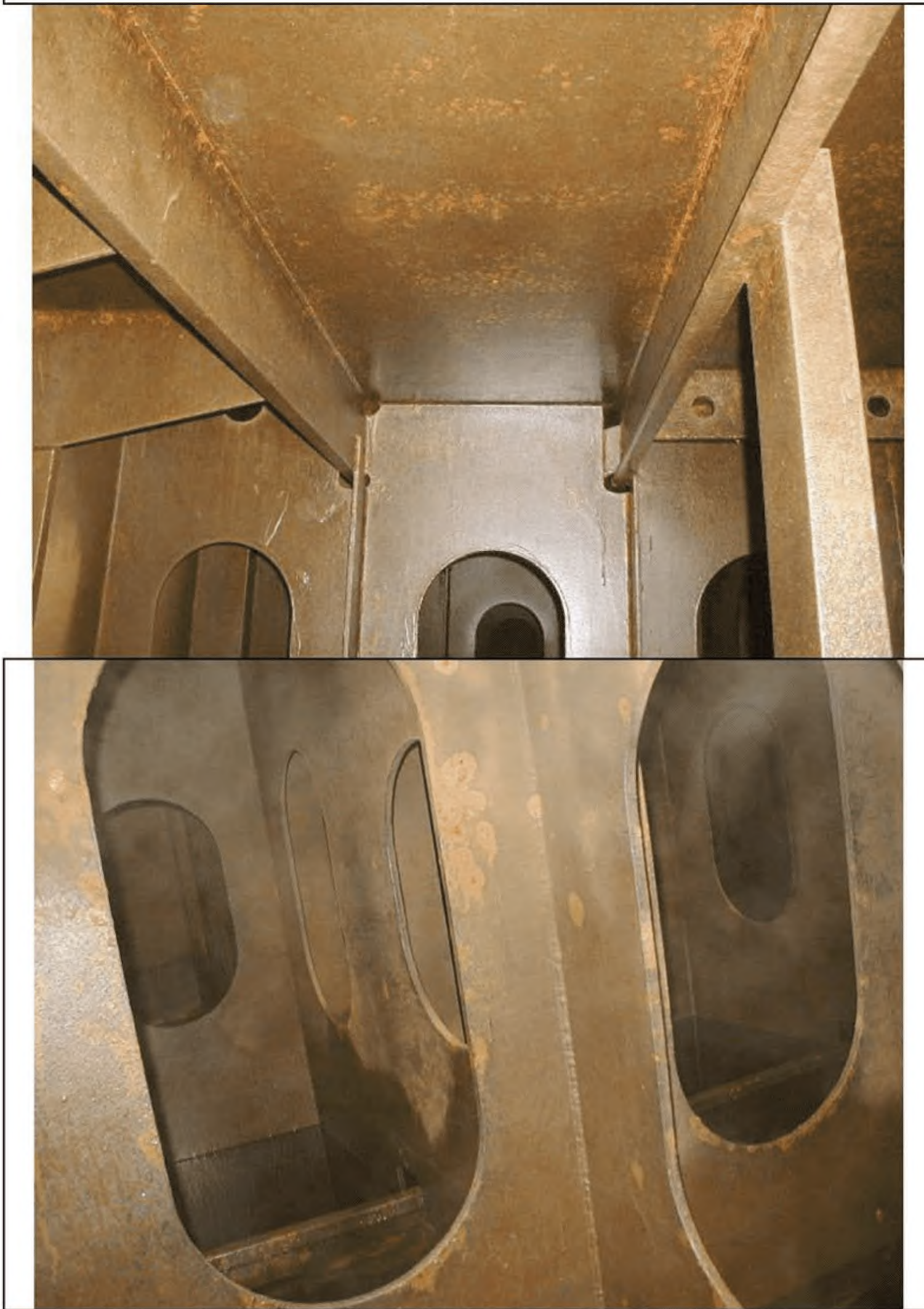
ХОРОШЕЕ СОСТОЯНИЕ ПОКРЫТИЯ
