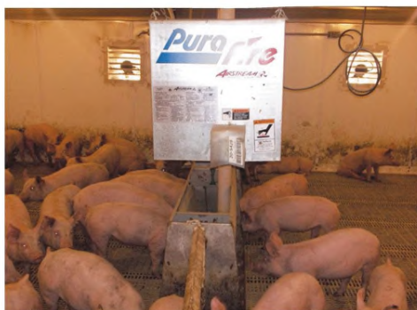
Рисунок 2.39 — Использование газовых теплогенераторов GSI в секторе поросят на дорацивании
