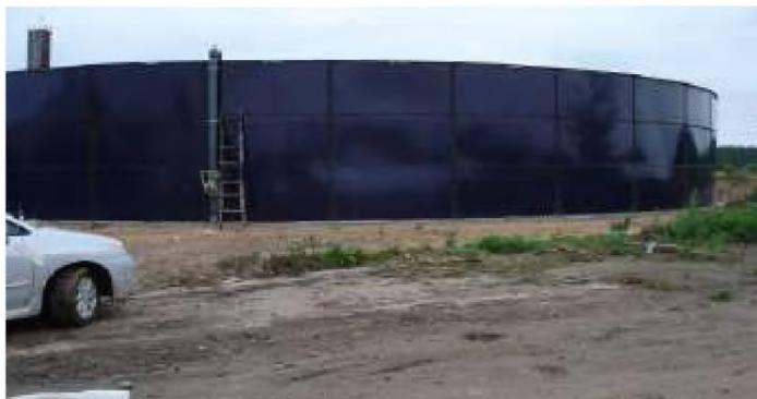
Рисунок 2.59 — Металлическое круглое хранилища (эмалированные стальные листы)
