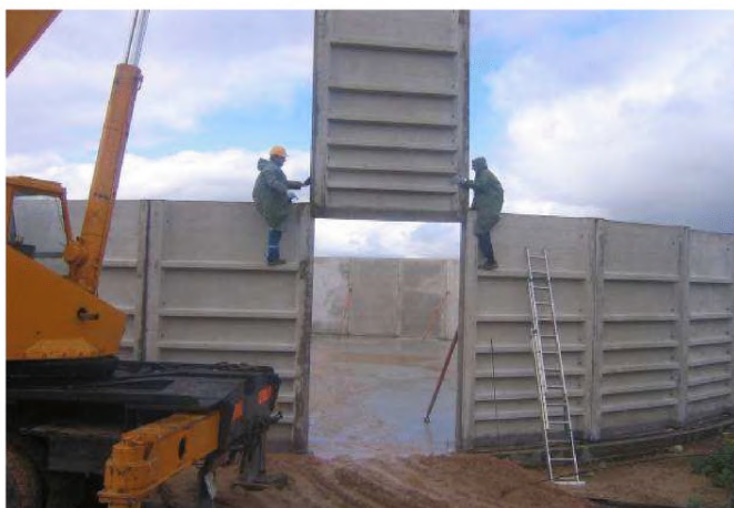
Рисунок 2.58 — Круглое сборное бетонное хранилище
