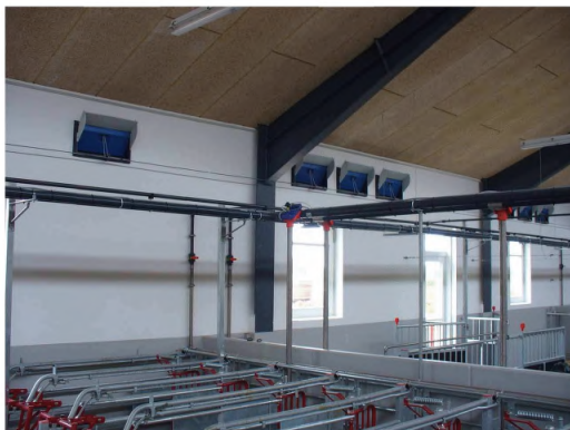
Рисунок 2.28 — Пример системы вентиляции с использованием приточных клапанов
