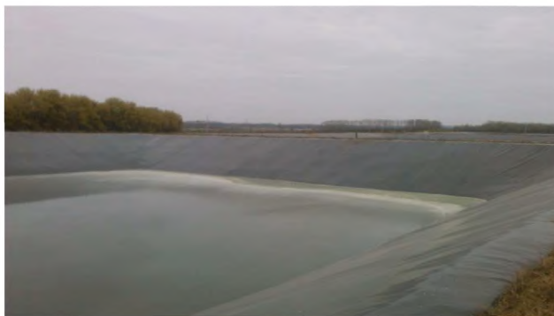
Рисунок 2.55 — Лагуна с пленочным покрытием только дна
