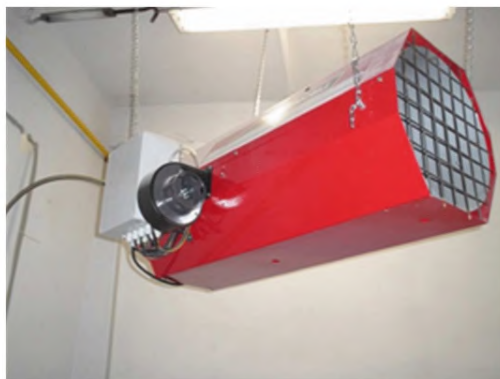
Рисунок 2.37 — Газовый теплогенератор-пушка
