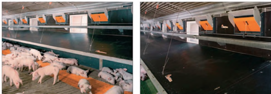
Рисунок 2.47 — Установка оребренных труб в секторе доразивания
