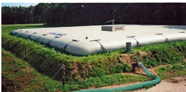
Рисунок 2.60 — Гибкий резервуар для хранения жидкого навоза
