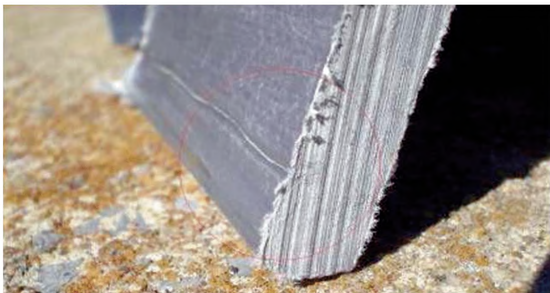
Рисунок А.7 — Волосяная трещина
