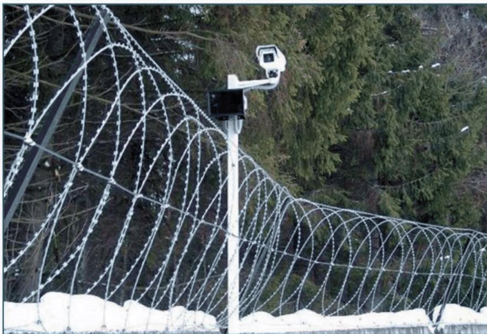
Рисунок 4. Установка ТК на столбе.
