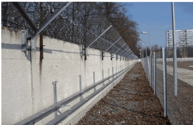
Рисунок 13. Инженерное оборудование периметра.
