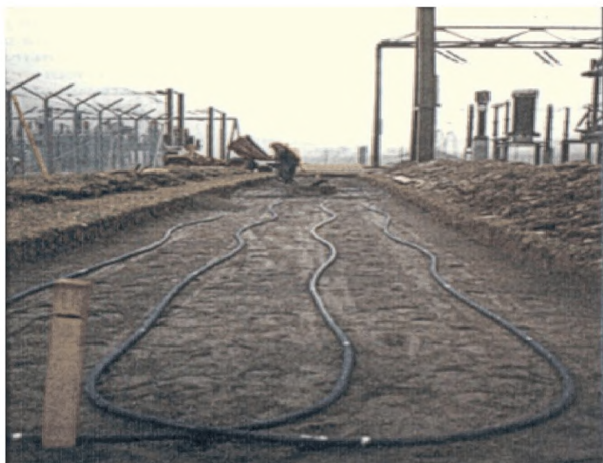
Рисунок 10. Установка чувствительного элемента (шлангов).
