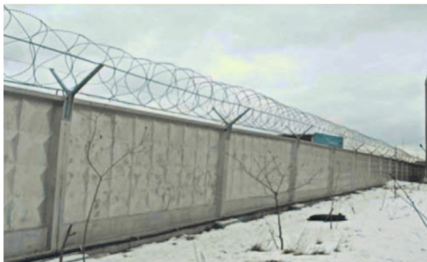
Рисунок 26. Бетонный забор с АКЛ.
