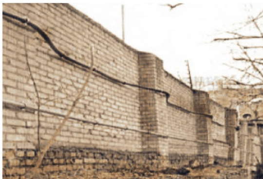
Рисунок 33. Установка ЧЭ на кирпичной стене.
