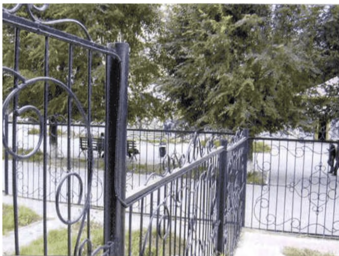
Рисунок 18. Установка извещателя на сварных решетках.
