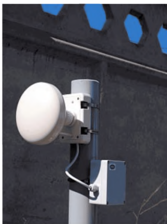
Рисунок 14. Пример установки РЛСО.
