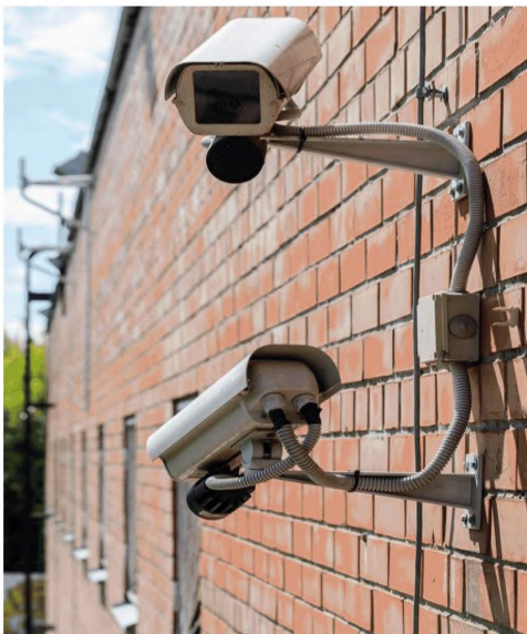
Рисунок 3. Установка ТК с ИК-прожектором.
