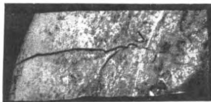
Рисунок А.26 — Трещины поверхностные
