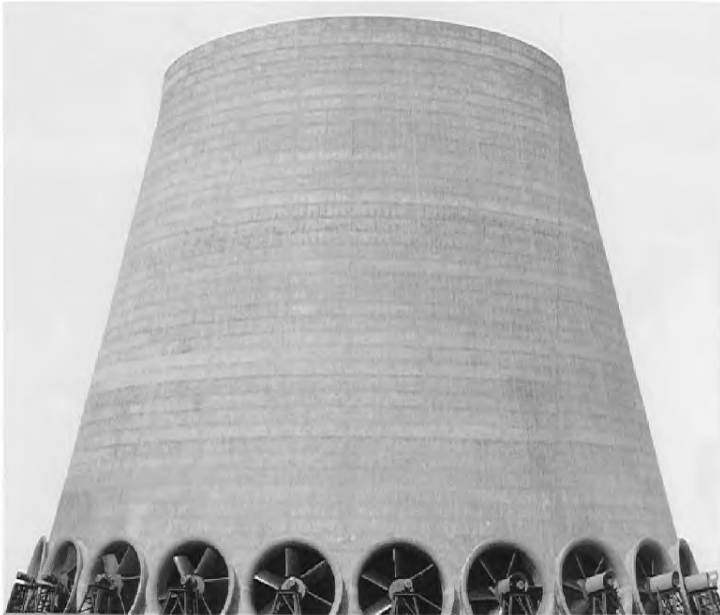
Рисунок 2.11 — Башенная градирня с естественной вентиляцией и вспомогательными вентиляторами ([9])
