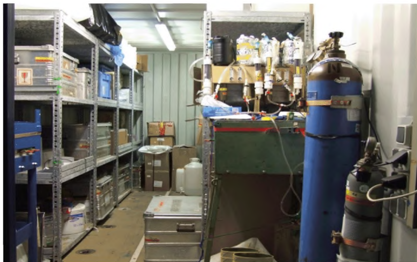
Рис.6.13 Пример внутреннего наполнения одной из современных контейнерных лабораторий (в данном конкретном случае измеряются так называемые геотрассеры, т.е. лаборатория химического направления). Такая лаборатория требует подключения к электричеству, но в наличии стационарного стока воды не нуждается.
