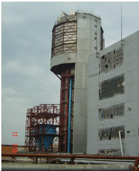
Рисунок 8.14 — Башня прилливания с металлическим стволом
