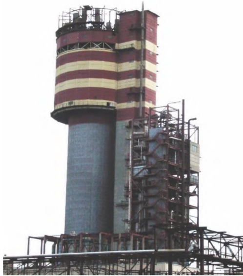
Рисунок 8.13 — Башня прилливания с железобетонным стволом
