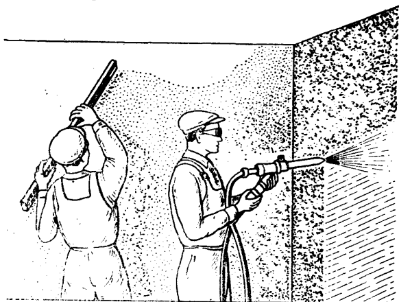
Рис. 6. Нанесение и разравнивание холодной асфальтовой мастики.
