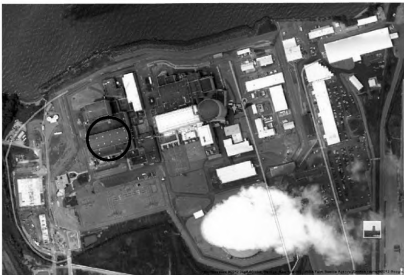
Рис. 5 Тепловизоры №4 и №5, размещенные на здании №2
