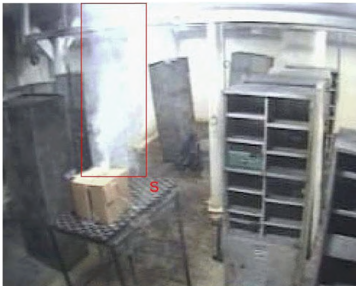
Рис. 74 - Работа видеодетектора дыма и огня Orwell IP-01
