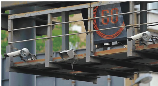
Рис. 51 - Размещения камер системы распознавания номеров на арке
