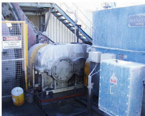
Рисунок С.5 – Редуктор со стороны двигателя
