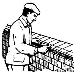
Рис. 32. Проверка горизонтальности ряда кладки
