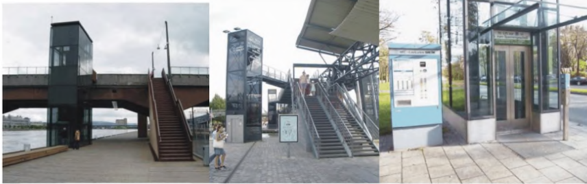
Рисунок 45 – Примеры пандусов и лифтов для инвалидов и других маломобильных групп населения на надземных пешеходных переходах
