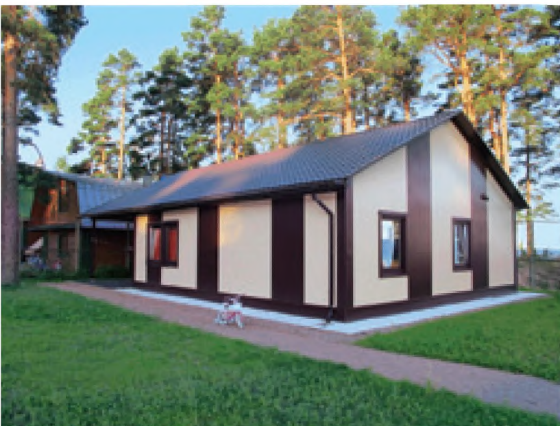
Жилой дом эконом-класса, Ленинградская обл.
